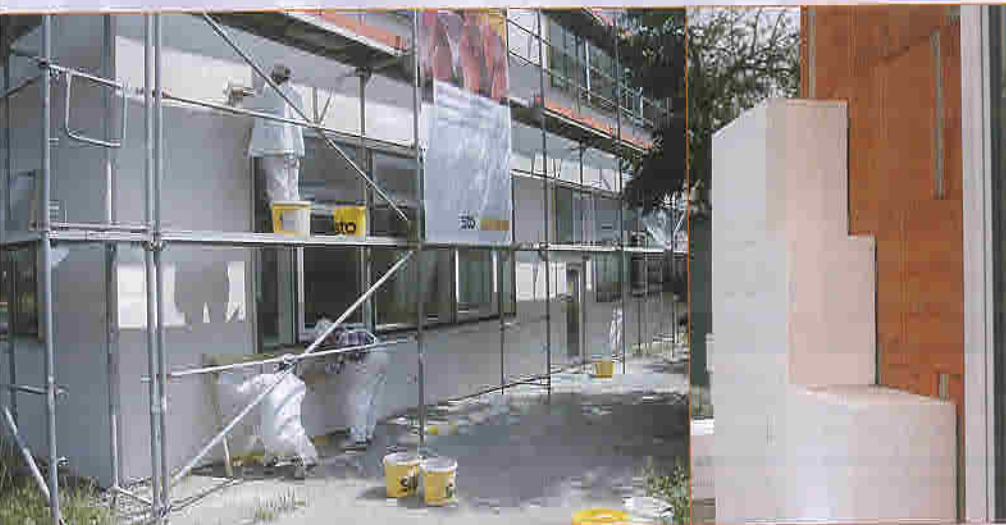
Ein Fall für das CO 2 -Gebäudesanierungsprogramm, Zuschüsse bis zu 8750 Euro pro Wohneinheit sind möglich, wenn der Energieverbrauch über 30% unter Neubau-Niveau sinkt. Foto: Sto AG
